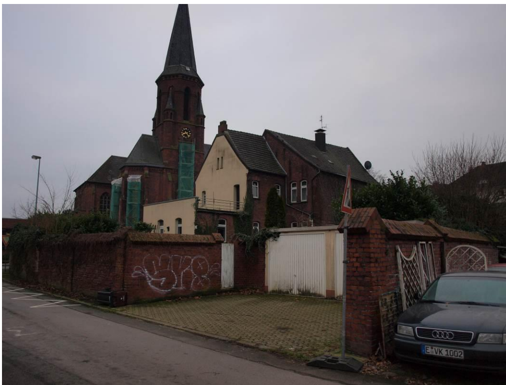
Foto 4: Blick von Bleichstraße auf westlichen Änderungsbereich mit zum Abbruch vorgesehenem Wohngebäude und von Mauer umgebener Gartenfläche (St. Bartholomäus Kirche im Hintergrund)
