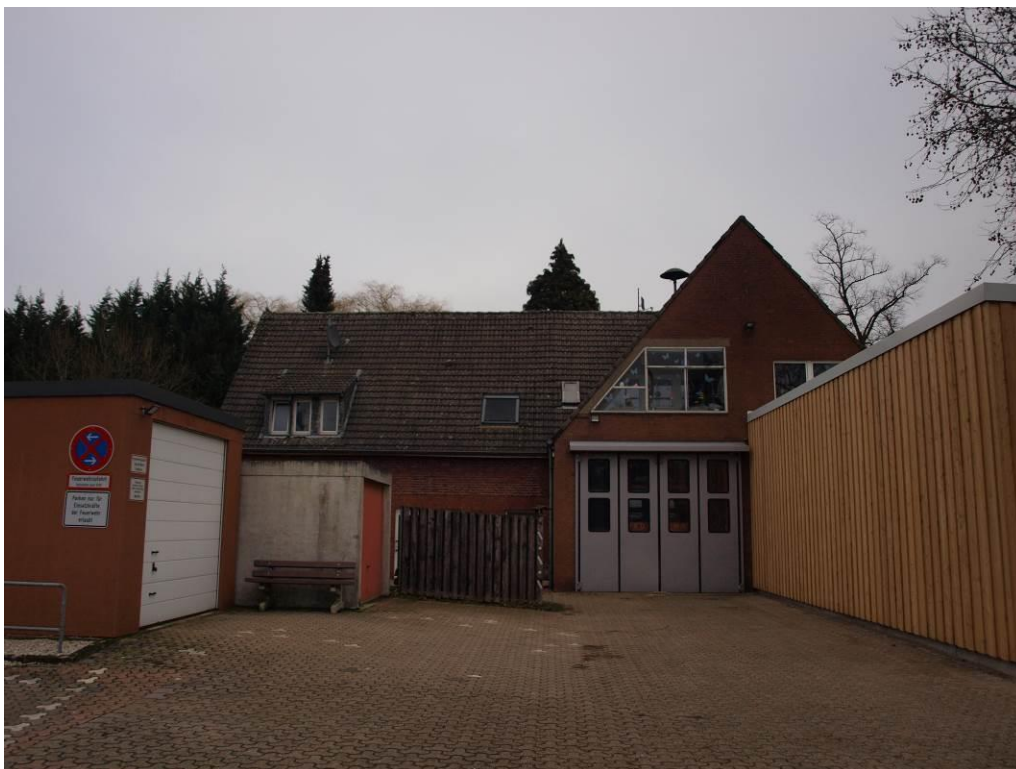
Foto 5: Blick von Westen (Bleichstraße) auf Feuerwehrhaus mit versiegelter Hoffläche und Garagen sowie Fahrzeughallen
