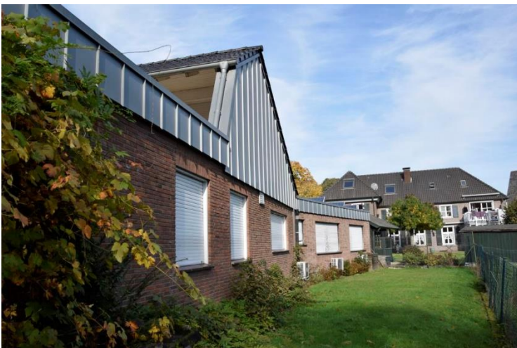
Östliche Gebäudefassade mit Roll-ladenkästen
