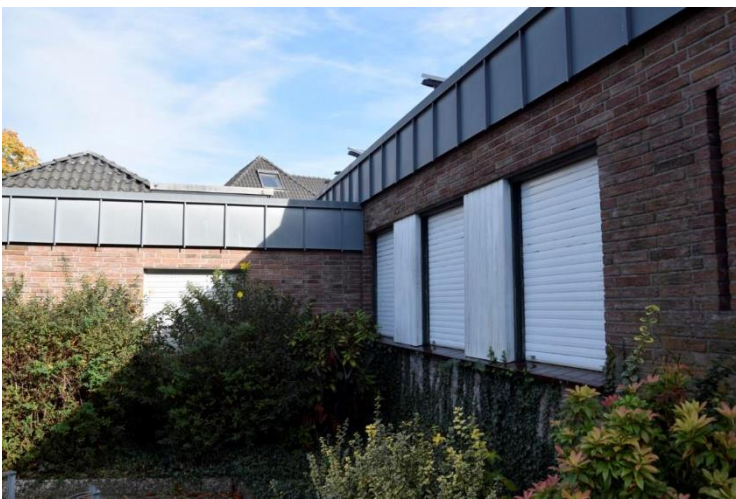
Außenansicht des Praxisgebäudes
