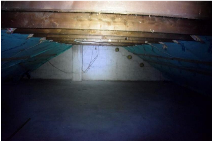
Der Dachboden war gut einsehbar
