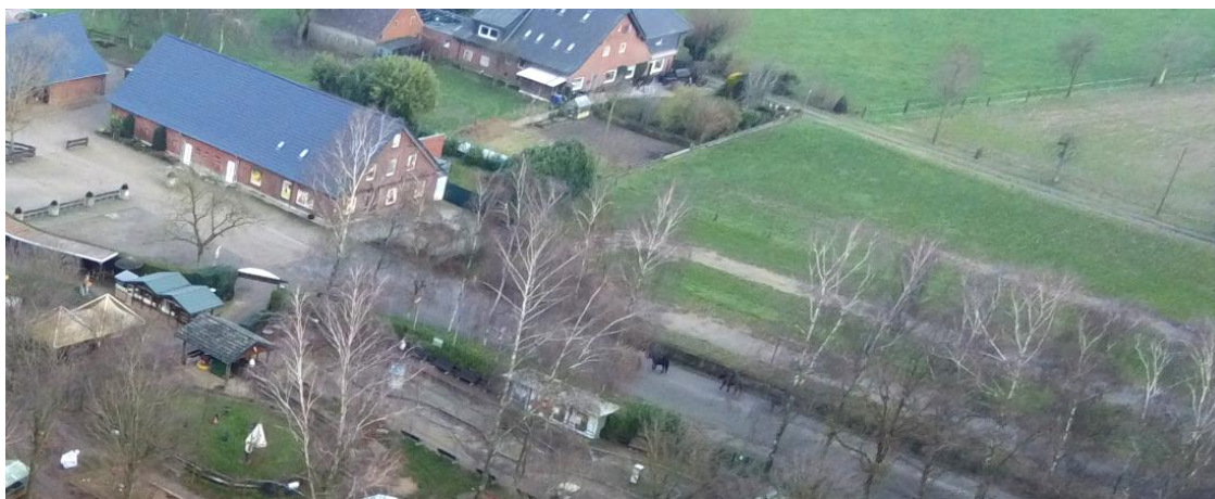
Foto 6: Frontseite leer stehende Scheune, Parkplatzfläche für Tagesgäste und Hof-Zufahrt
